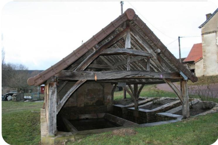
1ère action de l'équipe, ce lavoir nécessitait une grosse reprise, notamment au niveau de la charpente et de la toiture.
