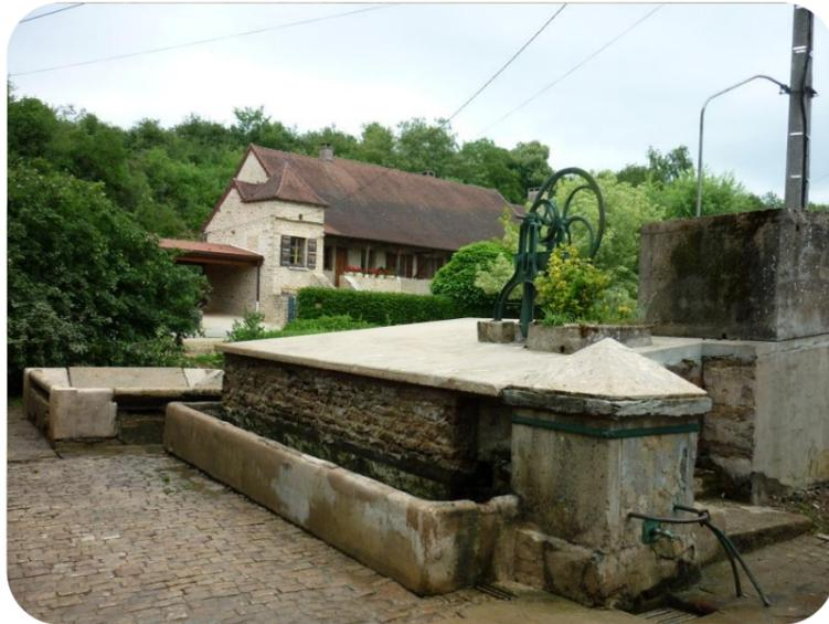
L'action arrive à son terme pour l'équipe. C'est tout un ensemble qu'il faut prendre en compte : mur de soutènement, dallage autour, abreuvoir, pompe, citerne... Le lavoir en lui-même se révèle en assez mauvais état concernant les maçonneries. A l'aide d'un nettoyeur à haute pression, le piquetage du mur au-dessus de l'abreuvoir, a tout de même meilleure allure!
