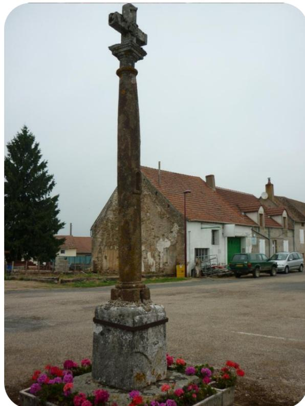
Un petit chantier pour le « sauvetage » du calvaire de la grand' place. Pensant initialement que le fût était fendu, et qu'il fallait déposer la pierre et la ferrailer de part en part à l'aide de tiges en inox, finalement, seule la partie externe de la pierre se décollait. Après avoir retiré les morceaux menaçant de tomber et purgé les parties pourries, le « puzzle » a été reconstitué le plus possible avec les pièces récupérées.
