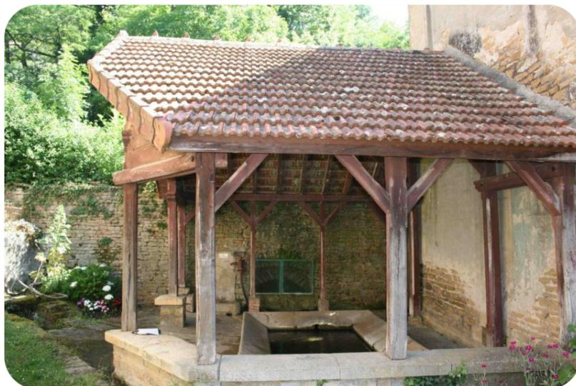
Ce lavoir, pourtant encore en eau, demandait néanmoins une restauration d'ampleur : charpente, couverture, et surtout peinture. C'est un chantier plus technique que les autres, du fait de la réalisation de l'enduit peint du mur mitoyen avec la propriété voisine : il a fallu restituer les fausses briques et les motifs des pierres d'angles.
