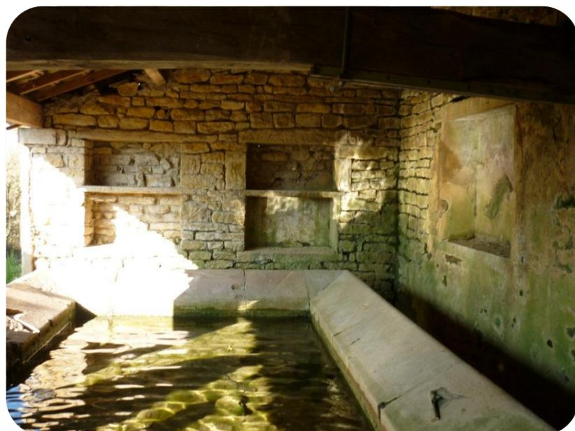
A flanc de colline, en direction du Mont Avril, ce lavoir nécessitait une remise à niveau urgente : charpente, en totalité, couverture à l'aide de tuiles mécaniques, et des reprises de maçonnerie.
