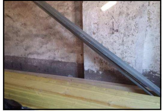
A l'étage, nous procédons à la dépose des anciennes solives, celles-ci ne permettent pas la pose du nouveau plafond au vu de leur état. Les nouvelles sont disposées de part et d'autre de la poutre centrale que nous renforçons préalablement à l'aide de demi-chevrons. Les chutes de solives sont réutilisées pour solidifier l'ossature.
