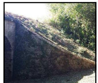
Sur ce pont nous devons refaire uniquement les maçonneries. Des pierres sont tombées avec le temps, laissant place à des trous que nous devons reboucher et un travail de jointoiement est nécessaire. Le chemin au-dessus sera équipé de barrières de protection similaires au pont de Dinay et au pont du centre-ville. Il nous faut monter un morceau d'échafaudage que nous récupérons sur le site du Puits Hottinguer.
