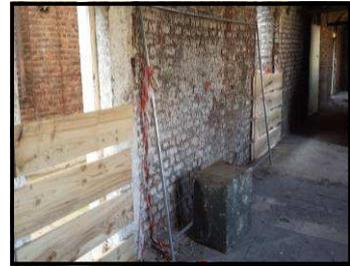
Les passerelles faisant la liaison entre les ailes doivent être sécurisées. Pour cela nous devons installer 2 bastaings de chaque côté (un au niveau du sol et un autre à 1m20). Des tirefonds sont utilisés pour la fixation, puis nous vissons des planches de 30 mm d'épaisseur dessus en laissant un espace d'une massette entre elles.
