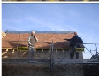
Les travaux sur le second rampant sont aujourd'hui bien avancés. Le chevronnage est callé, la sous-toiture posée et le litage en bonne voie. Mais en raison du vent fort qui souffle depuis ce week-end, nous avons, pour des questions de sécurité, protégé la toiture par une bâche et interrompus le travail. Nous reprendrons dès que les conditions seront plus clémentes.
