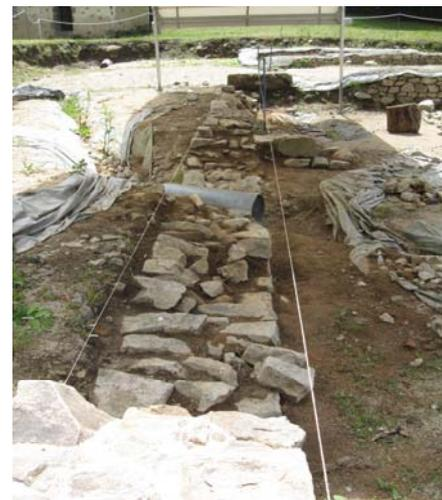
Nous devons restituer la base du mur d'un côté avant l'autre de plusieurs rangs car les pièces ne sont pas à la même hauteur. Le mur que nous restaurons est traversé par une canalisation. Nous avons donc placé un morceau de PVC pour ne pas la condamner, peut être la Domus sera-t-elle remise en eau par la suite.
