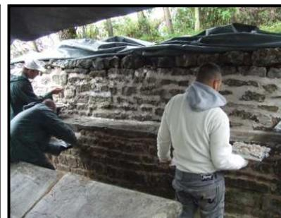
Dans le même temps, un groupe s'occupait de tailler la pierre qui servira d'arrivée d'eau (en remplacement de l'arrivée d'eau en inox). Après avoir été nettoyé et brossé, l'étanchéité intérieure et extérieure du bassin a été refaite par maçonnerie.
