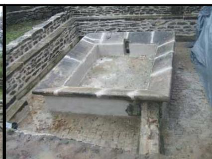
A cause des intempéries de pluie, ces platines ne tenaient pas fixées malgré le mortier ; nous avons donc laissé le chantier en suspens après l'avoir mis au propre.
