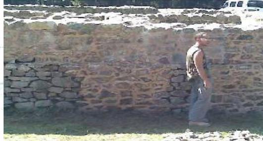
J'ai commencé le travail par gratter les joints des murs en place et les enduire de mortier.
