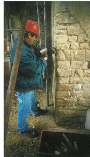
crépi. Cela consiste à préparer un mortier composé de trois seaux de sable,  $\frac{3}{4}$  de seau de chaux aérienne,  $\frac{1}{4}$  de seau de chaux hydraulique. La chaux hydraulique, en plus de faciliter la prise du crépi, atténue les désavantages liés à l'humidité.
