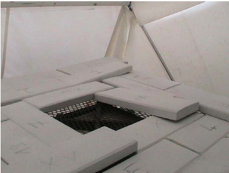
Assemblage des plaques de fond
