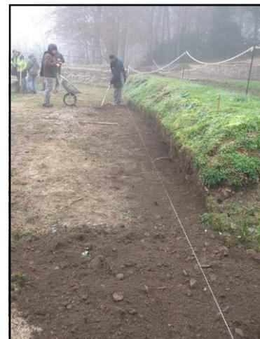
Au centre de recherche de Glux-en-Glenne nous avons créé deux escaliers pour descendre au parking. Nous avons découpé des bois à la mesure désirée et des piquets en châtaignier pour les fixer. Le sol a été décaissé puis les rondins placés à égales distances. Pour stabiliser l'ensemble, après avoir placé un géotextile, du tout-venant a été damé. Le gravier déposé sur le dessus des marches permettra une descente facile. Finition et nettoyage du chantier pour finir.
