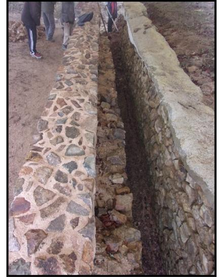
Les binômes formés, nous entreprenons le nettoyage et la remise en état de l'hypocauste, enlevons toutes les feuilles mortes et mauvaises herbes et ratissons les sols. Quelques réparations vont être nécessaires, le mortier de chaux reliant les pilettes entre-elles s'étant dégradé avec le gel. Les fenêtres archéologiques montrant la canalisation qui traverse la Domus sont aussi nettoyées, tout est net pour les premiers visiteurs qui se lanceront à l'ascension du Mont Beuvray.
