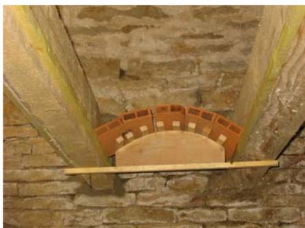
Afin de mettre au point le gabarit, nous avons réalisé plusieurs essais qui nous ont permis d'ajuster le réglage du gabarit et de régler les quelques défauts que nous avons observés
