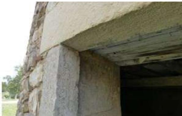
*Détail du linteau et d'un piédroit de la porte. Les pierres présentent une face de parement bouchardée avec une ciselure périphérique : mise en oeuvre XIXe siècle.*
