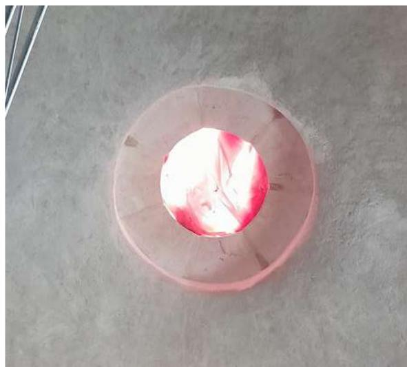
Démontage de l'étalement de la voûte et enduit de l'intrados de la voûte en quatre passes
