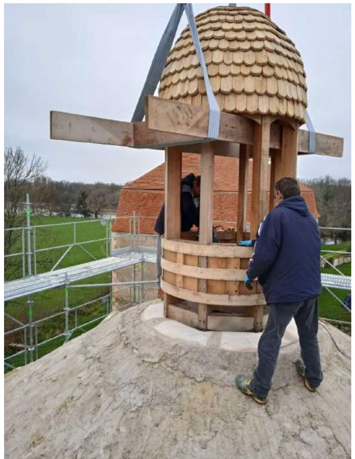
Pose des bardeaux de châtaignier à la base du lanterneau et pose des protection en plomb
