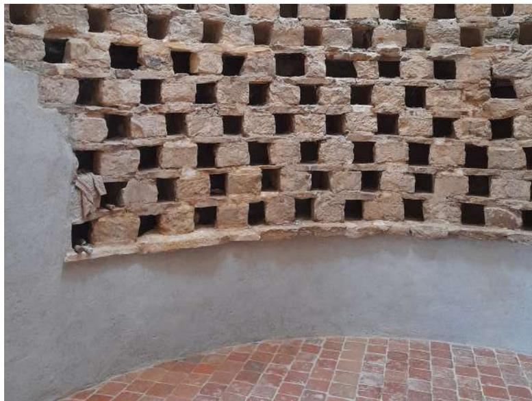
Dégagement des trous de boulins, dépose du plancher intermédiaire et consolidation de la corniche à la base de la voûte
