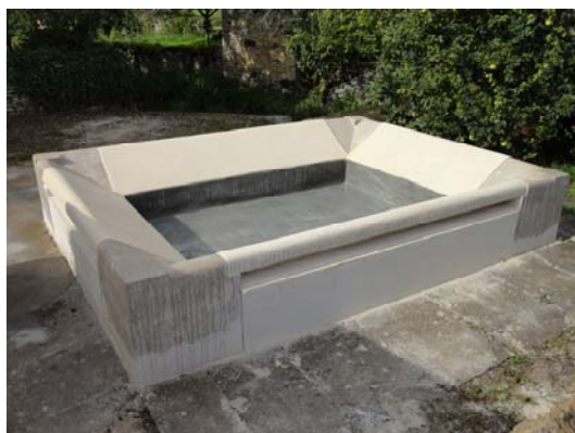
Réalisation de l'étanchéité du bassin et des marges
