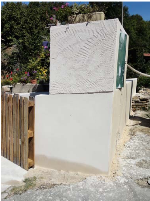
Reprise des enduits en deux couches
