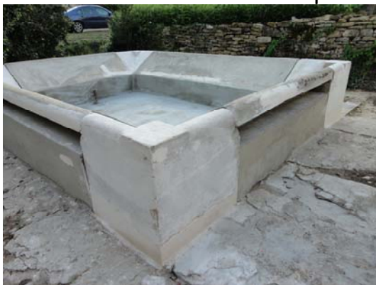
Réalisation de l'étanchéité du bassin et des marges
